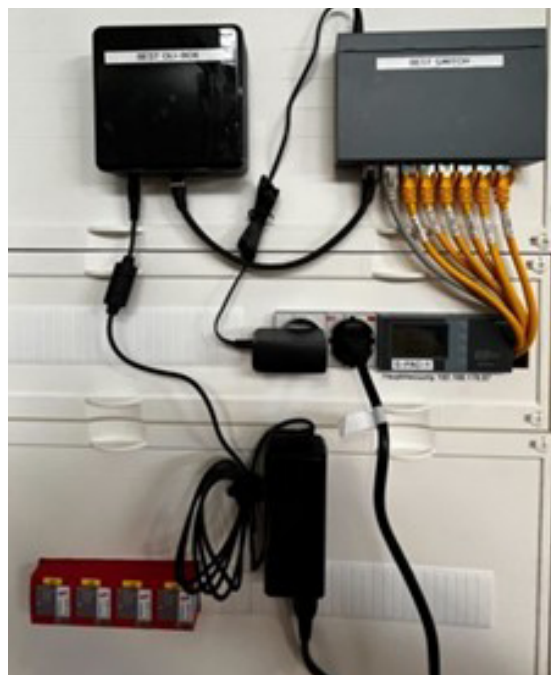
Abbildung 10: Installation der speziellen Hardware an einem Teststandort. Auf der BEST-OLI-Box sind das dezentrale BEST-System mit Bietagent und das lokale Energiemanagementsystem in Betrieb.
